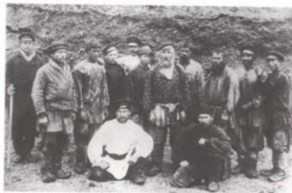
Строители Ташкентской ж. д. 1903 г.
